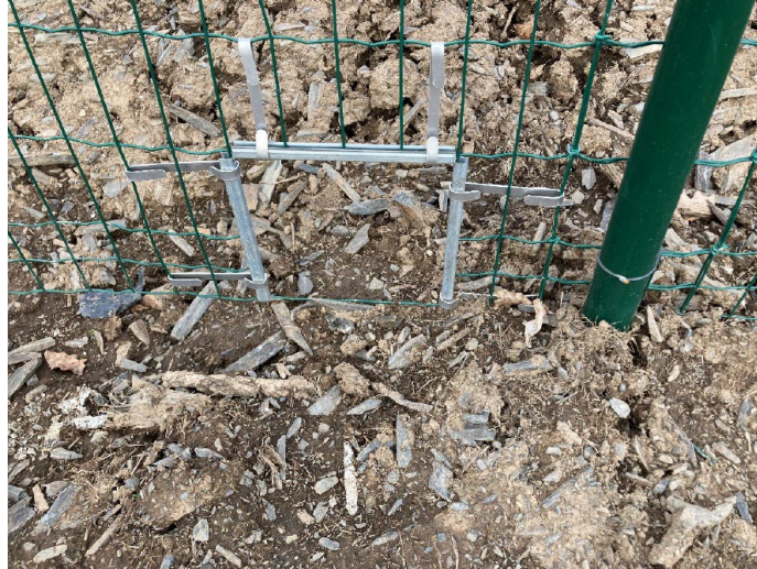
Figure 2 : Exemple de clôture équipée d'un passage pour la petite faune sur un projet construit
